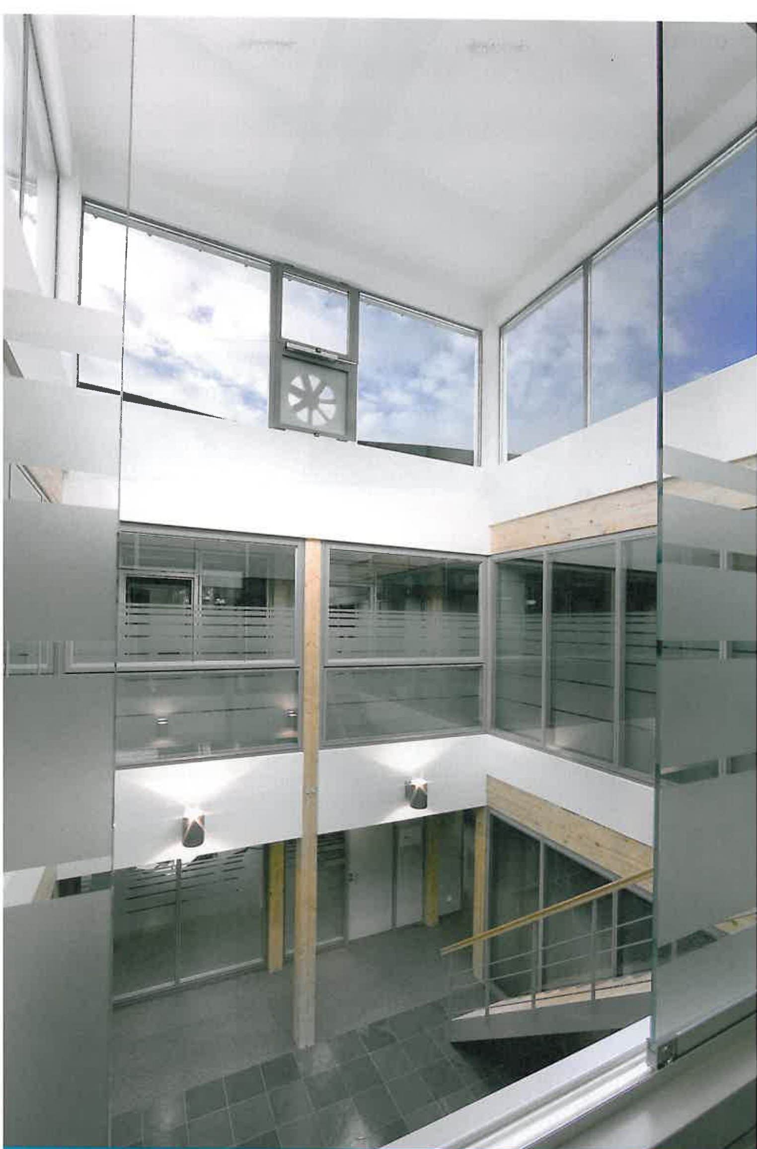
is le couloir supérieur vers le patio. Des vitres de verre partiellement sablé préservent la discrétion de l'étage tout en laissant pénétrer la lumière de jour.
